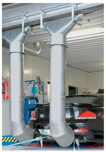
Много горячего выхлопа: Системы удаления выхлопных газов при мощностных испытаниях должны отвечать значительно более высоким требованиям, чем в обычном сервисе.
