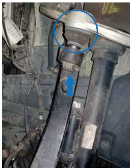
Фото 7. Знос/пошкодження кульових опор важеля підвіски
